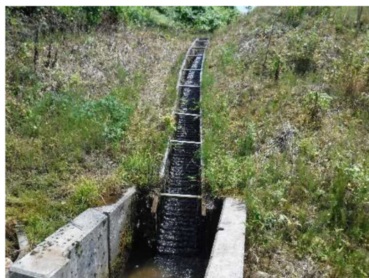
波付フリュームの設置状況
