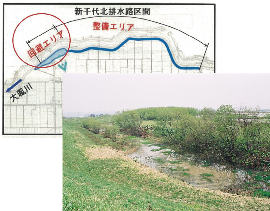
新千代北排水路における回避区間の状況
