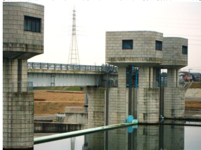
佐賀中部地区(佐賀県佐賀市)
