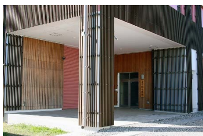
整備後（入口部）
