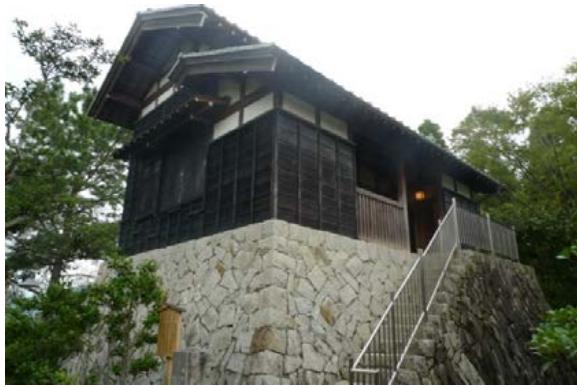
〔保全されている水屋の外観〕
