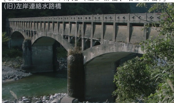
(旧)左岸連絡水路橋
