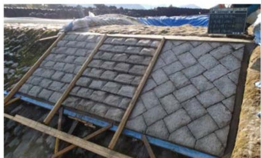
[試験施工状況 (左No.1、中No.2、右No.3)]
