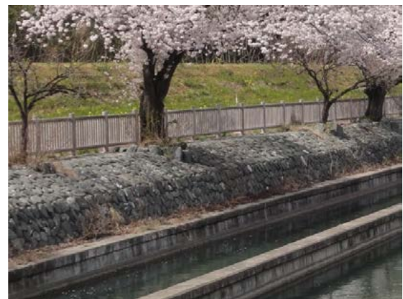
〔三波石を用いた護岸〕
