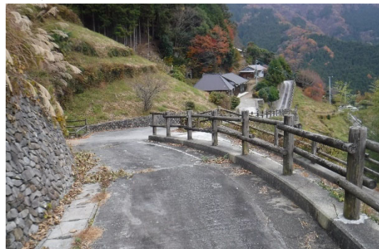
〔間伐材使用の防護柵〕
