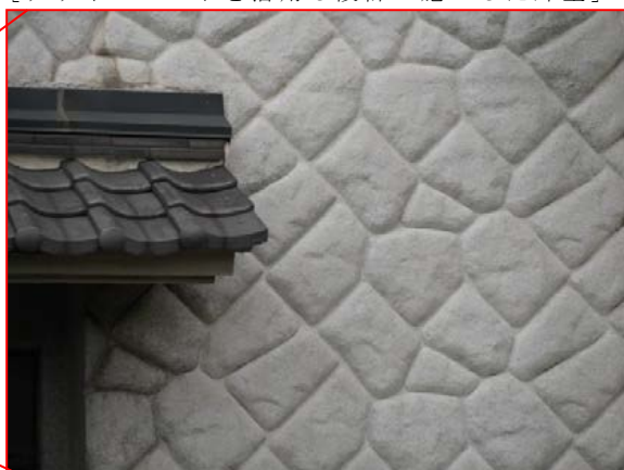
〔デザインコードを活用し設計・施工した外壁〕
