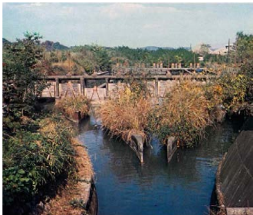
〔沈砂池の改修後の開放区間〕
