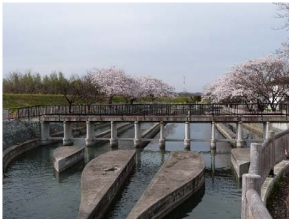
〔沈砂池の改修後の開放区間〕
