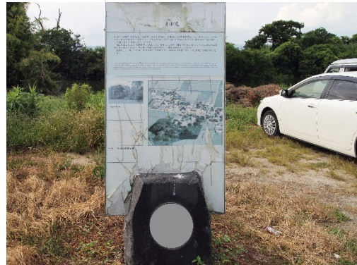
〔素材が経年劣化した看板〕
