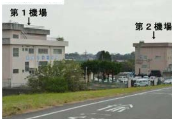
〔旧与良川橋より〕
