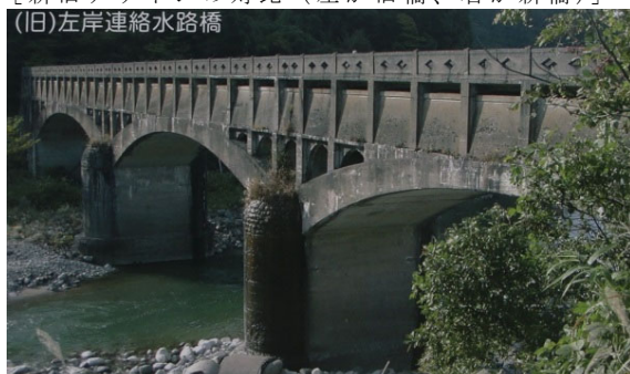
(旧)左岸連絡水路橋
