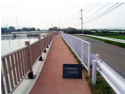
〔木柵が設置された更新前の管理用道路〕
