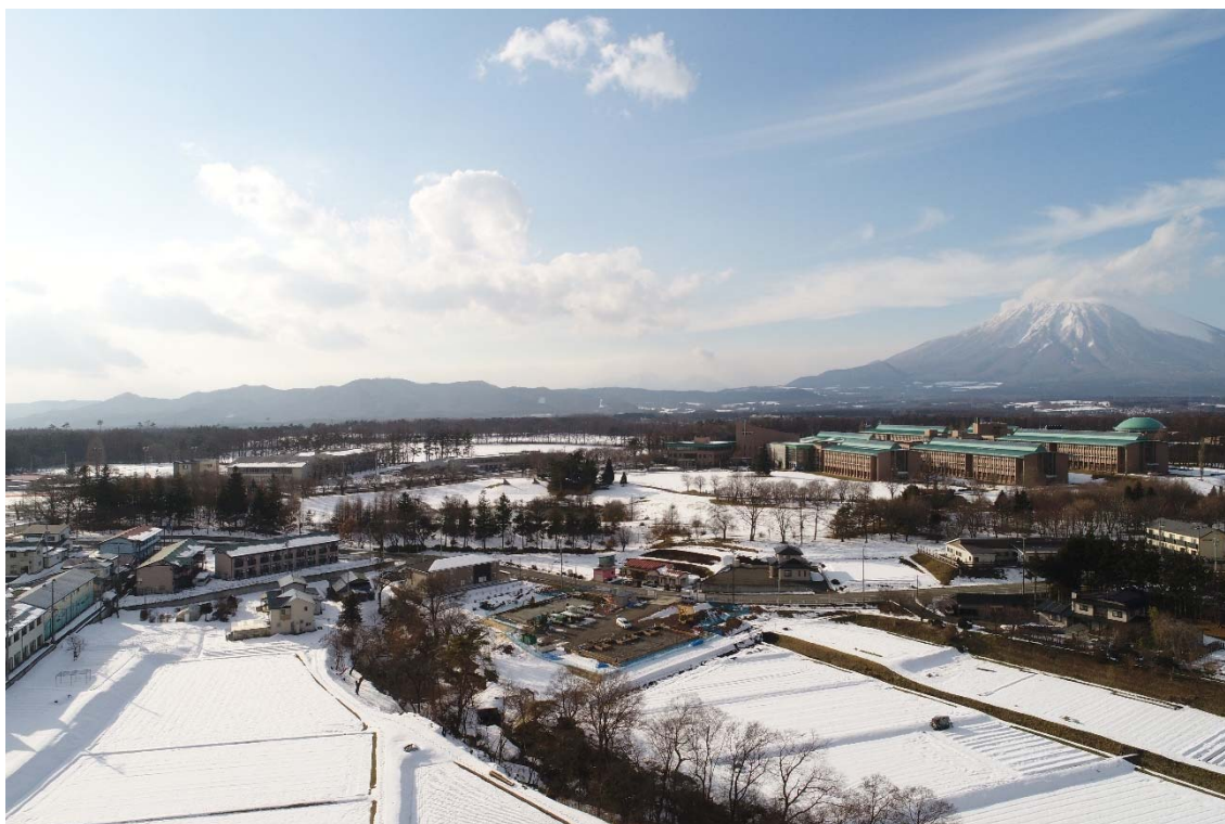
図 16 地域景観の概況把握（シンボリックな景観構成要素、土地利用状況等の確認）
