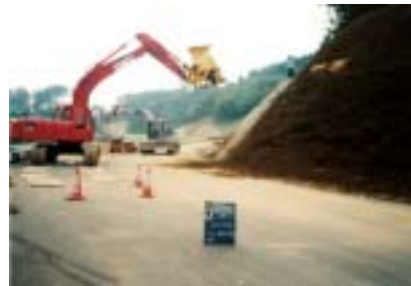
チップを種子・肥料等と混合し緑化材として、法面にまき出している状況
