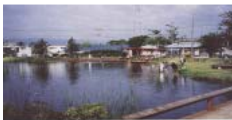
水環境整備事業三島中部地区
