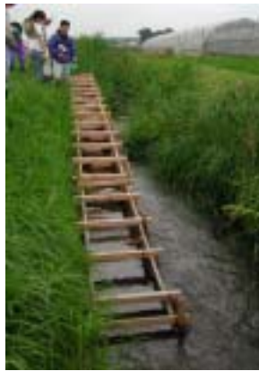
簡易な魚道での遡上試験のイメージ (写真：栃木県 小貝川西 期地区)
