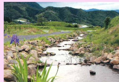
◀現場発生石材を再利用した石積み水路（イワナ水路）と散策路
