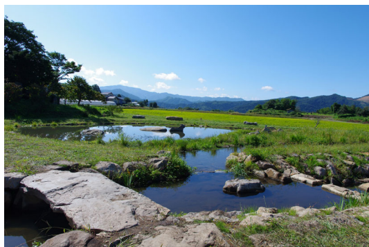
▲施工直後の保全池の様子
