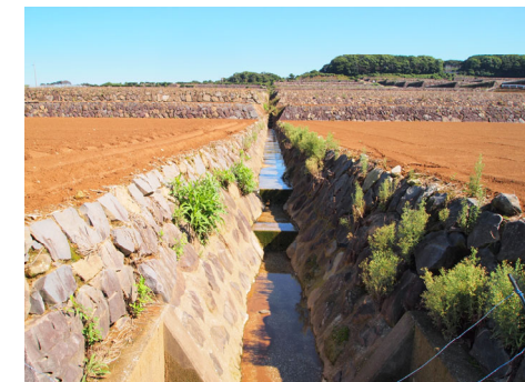
▲ 石積みで整備した水路
