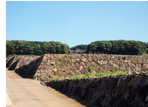
▲ 農地の法面に整備した石積み
