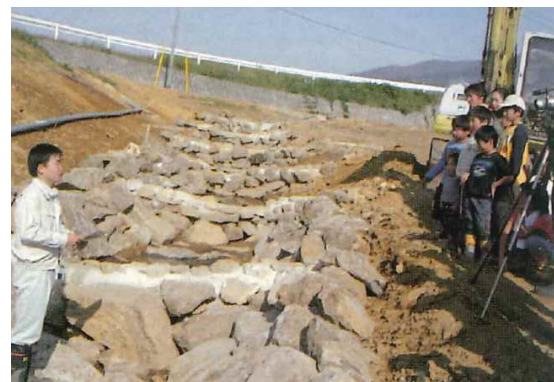
▲現場発生石材を再利用した石積み水路の工法を地域住民へ説明する様子
