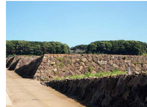
▲ 農地の法面に整備した石積み
