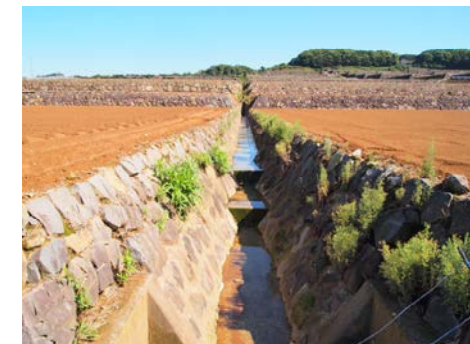
▲ 石積みで整備した水路
