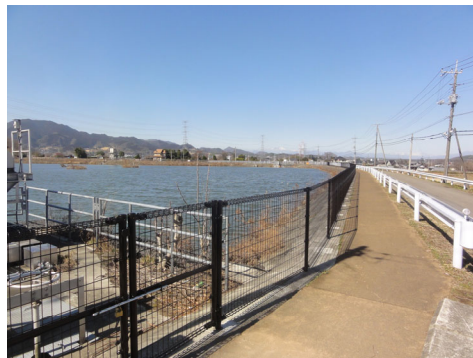
▲木柵から金属製フェンスへの更新
