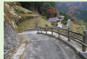
▲間伐材を用いた防護柵
