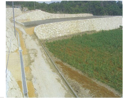
▲石灰岩を用いた石積み擁壁（整備直後）
