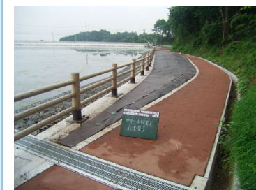
◀新設された南側管理用道路
