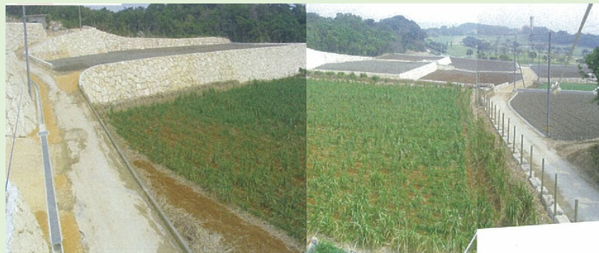
▲琉球石灰岩を用いた石積み擁壁（整備直後）
