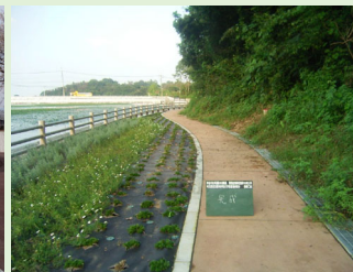
▲羽根倉池の管理用道路（完成直後）
