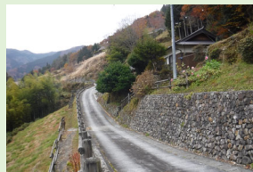
▲切土側の石積み
