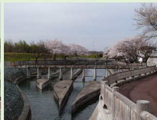
▲沈砂池の管理用道路
