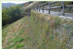
▲植生による壁面修景
