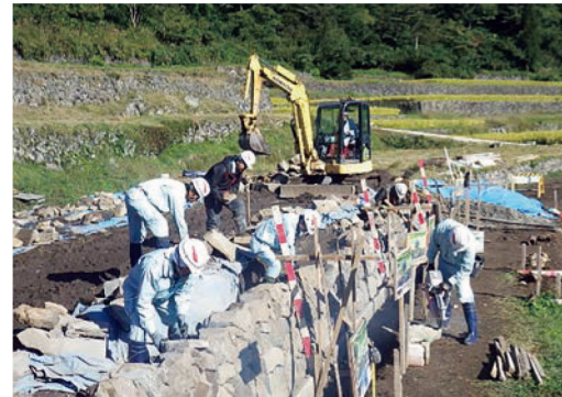
▲石垣の復旧作業
