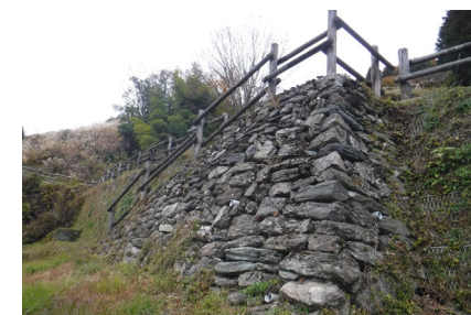
▲現場発生材を用いた石積み工
