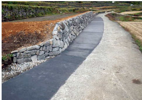
▲道路拡幅と石垣復旧完了
