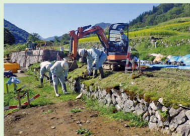
▲手作業による石垣の撤去
