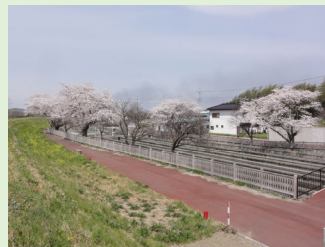
▲沈砂池の管理用道路
