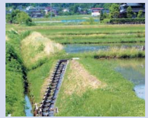
水田に設置された魚道 (写真提供:兵庫県但馬県民局地域振興部豊岡土地改良事務所)
