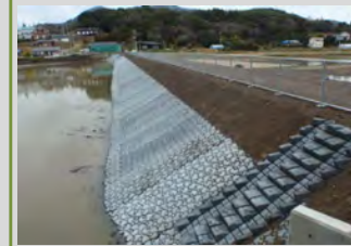
ため池護岸の整備
