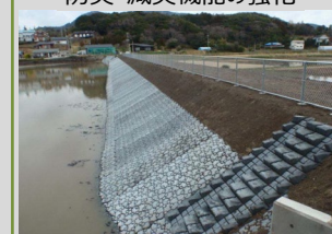
ため池護岸の整備
