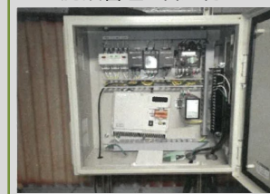
監視装置の設置
