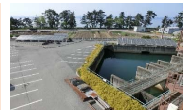
【揚水機場と太陽光発電】
