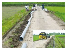
水路のパイプライン化
