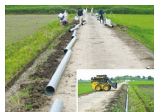
水路のパイプライン化
