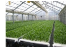
農業生産施設 （水耕栽培ハウス）
