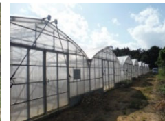
【農業用ハウスの整備】
