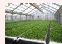
農業生産施設(水耕栽培ハウス)
