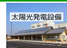
太陽光発電設備
