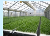
農業生産施設(水耕栽培ハウス)
