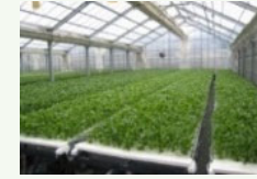
障害者等が作業に携わる生産施設の整備
