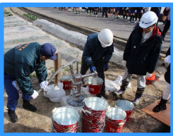
防災訓練や防災兼用井戸の整備
