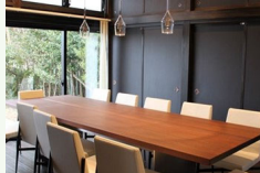
食の高付加価値化に不可欠な内装の改修
