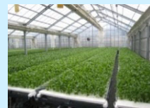
農業生産施設(水耕栽培ハウス)
