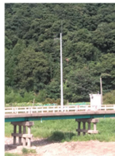
防災無線(公共施設)
