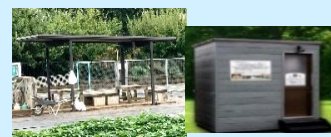
休憩所、トイレの整備
