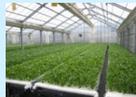
農業生産施設（水耕栽培ハウス）
