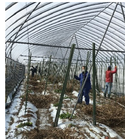
作業請負 (ハウスの片づけ)
