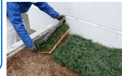
マットタイプを利用した造園施工の様子
