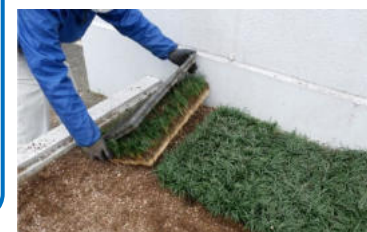
マットタイプを利用した造園施工の様子
