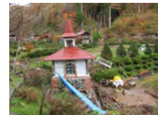
被災した施設
