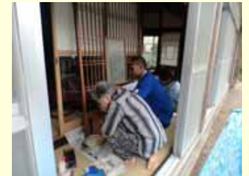
海外研修生と古民家再生作業
