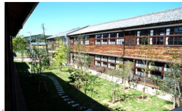
廃校舎を活用した交流施設 (秋津野ガルテン)
