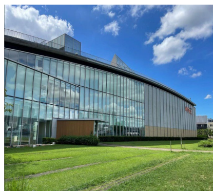
農園設置場所となる東京ガス「がすてな-い」の様子
