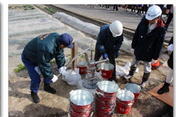
防災協力井戸の設置
