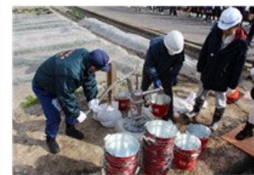
防災協力井戸の設置
