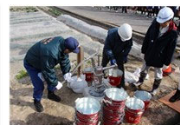
防災協力井戸の設置
