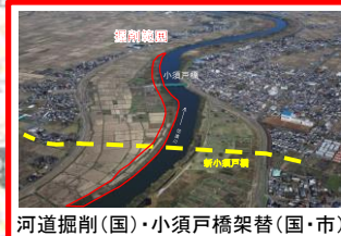
河道掘削(国)・小須戸橋架替(国・市)
