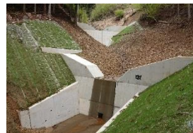
治山ダムの整備(愛知県)
