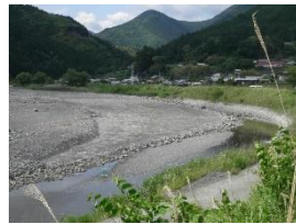
河道掘削(静岡県)
