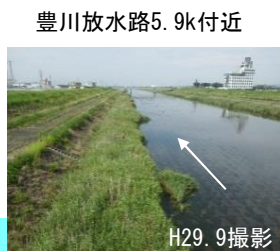
(ヨシ原創出後の豊川放水路)
