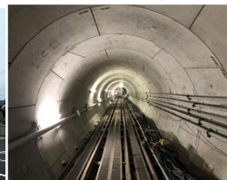
■工事中の八帖北幹線
