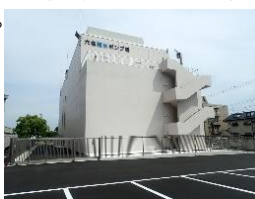
■六名雨水ポンプ場
