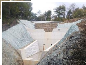
治山施設の整備 （岐阜県）
