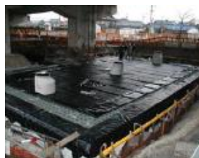
雨水貯留施設の整備 （大治町）
