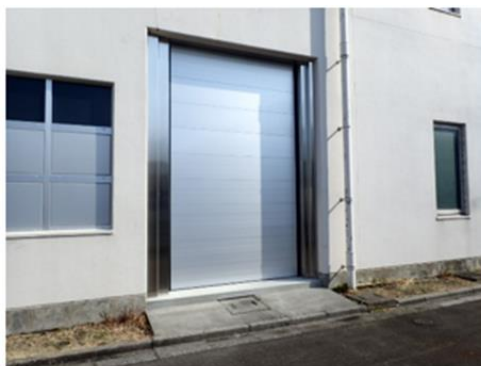
防水シャッターの設置
