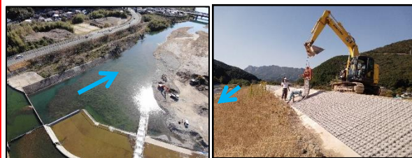
祝子川【河道掘削工事】
