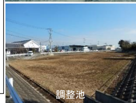
貯留施設設置状況
