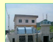
排水機場の整備
