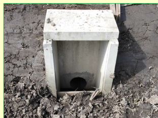
排水口の整備
