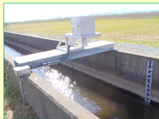
水位計の設置
