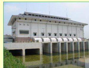
排水機場の管理
