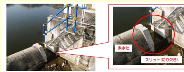
農業用ため池の洪水調節機能を強化するための「洪水吐きスリット」設置状況
