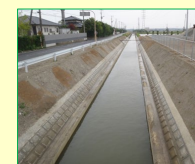
排水路の整備
