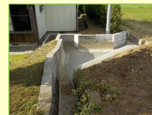
排水路側壁嵩上げ
