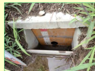
排水調整板の設置
