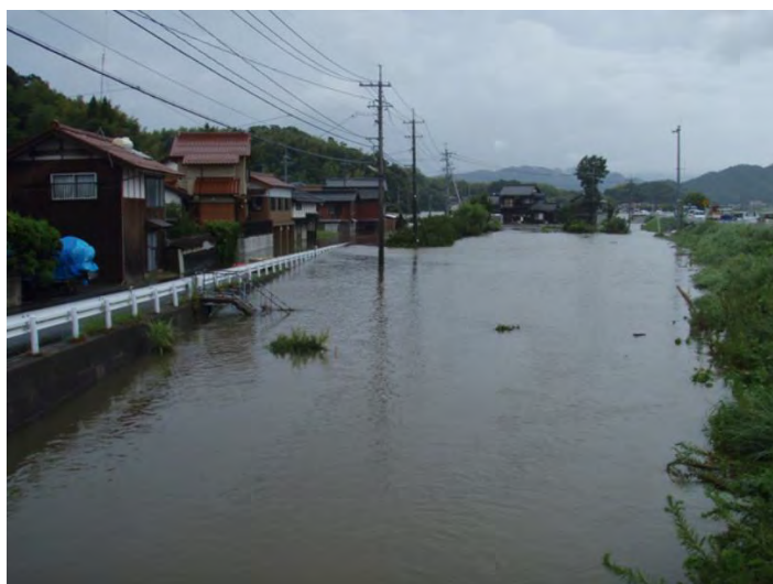
写真 2-2 小河川からの浸水（平成 23 年 9 月洪水 日野川水系小松谷川）
