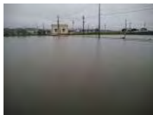
平成30年西日本豪雨時の状況
