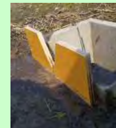
調整板の設置状況
