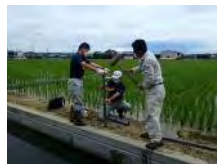
実証実験の機器設置
