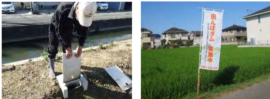
図 7-6 流出量調整器具の設置(左) のぼり旗の設置状況(右)
