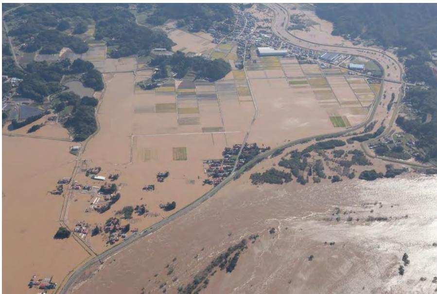
写真 2-5 本川からの浸水（令和元年10月 阿武隈川水系阿武隈川）
