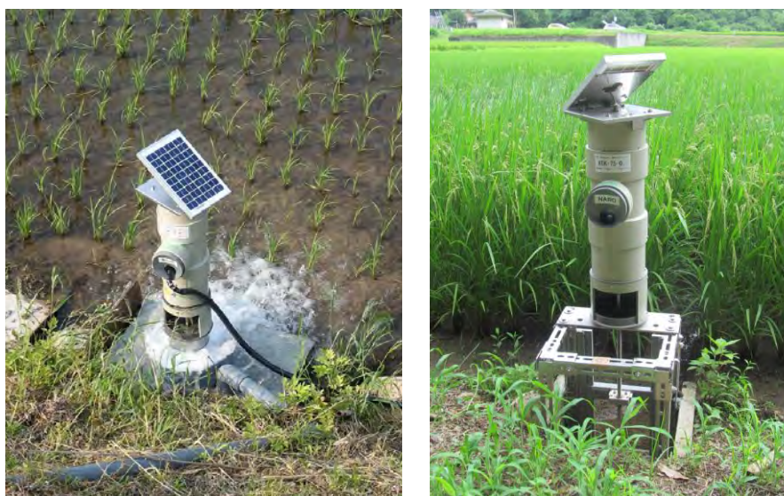
写真 7-1 左 自動給水栓設置例 右 自動排水栓設置例
