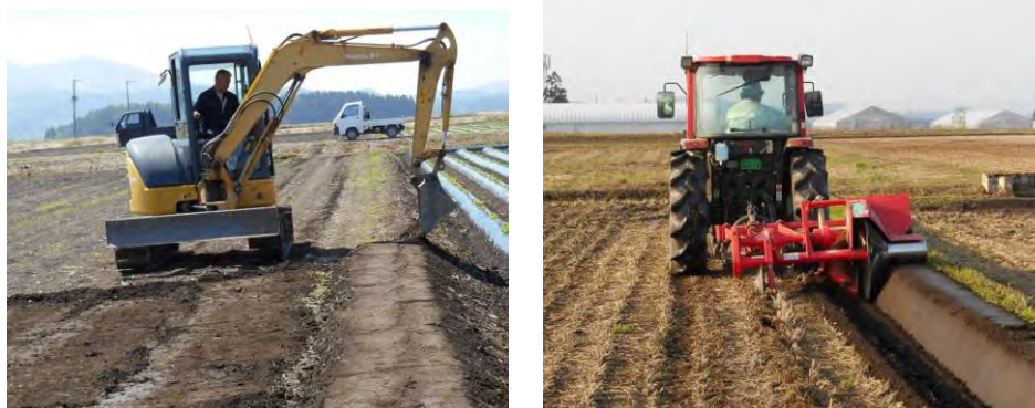
写真 2-6 左 畦畔の再構築 右 畦畔塗り
