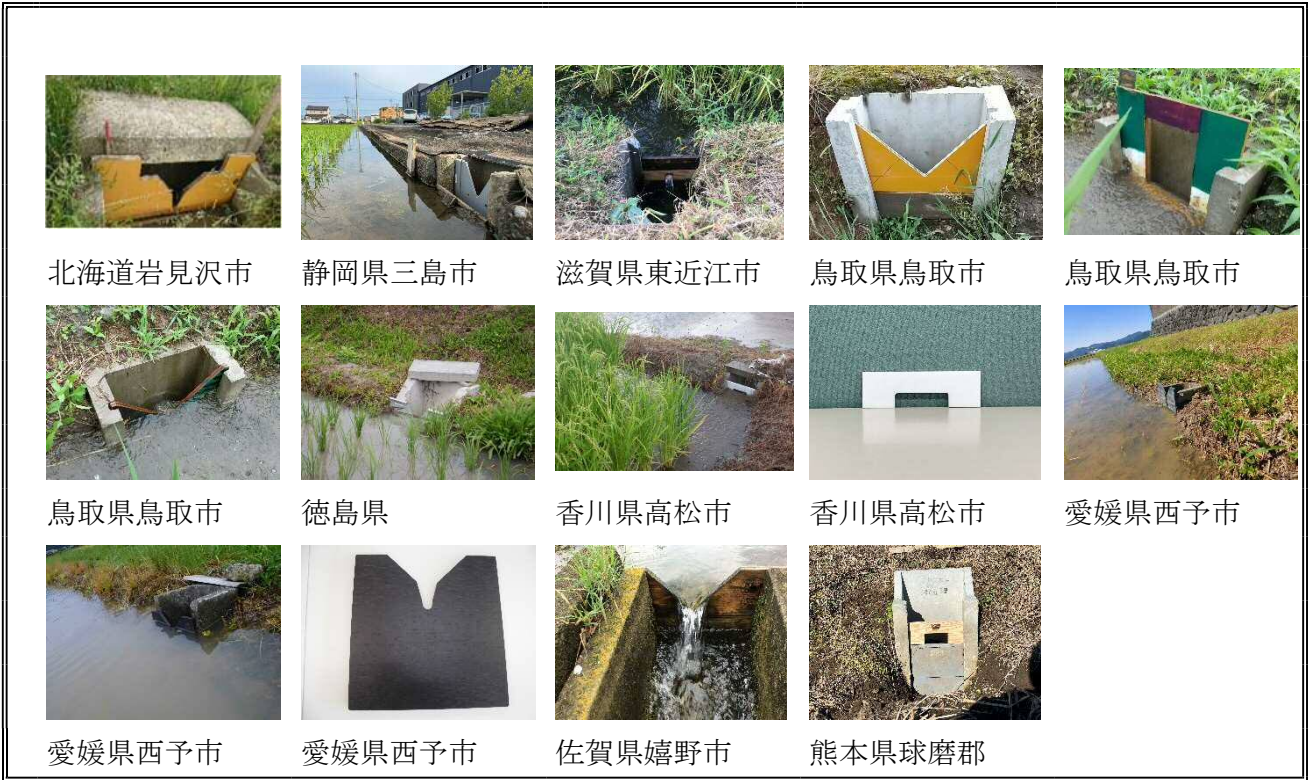
図 - 2 流出量調整器具（機能一体型）の写真
